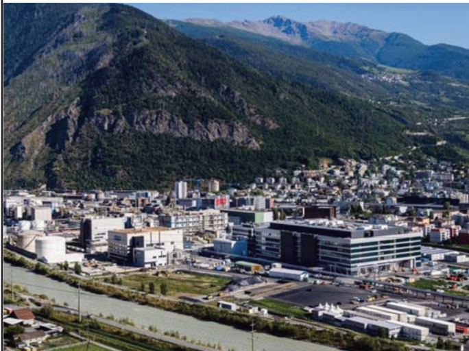
Les émissions de protoxyde d'azote du site devraient être réduites d'au moins 98%. KEYSTONE/ARCHIVES
